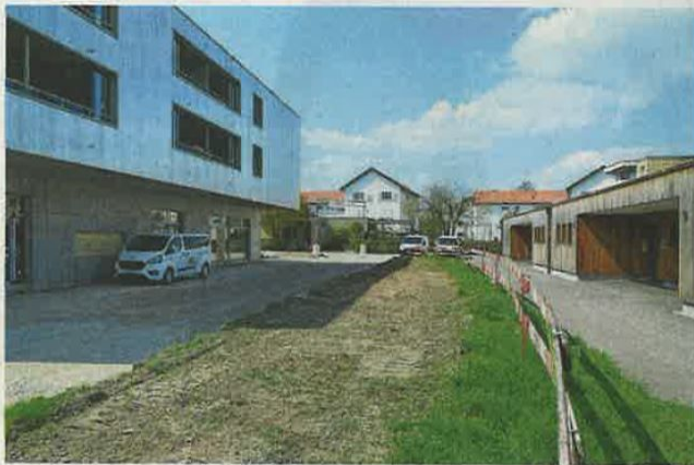
Das Töpferhaus (links) ist praktisch fertig gebaut. Der Platz zum Kindergarten hin wird nun gestaltet.
